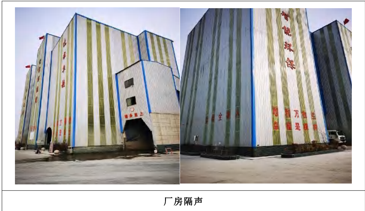
图4.3 本次验收项目噪声治理设施
